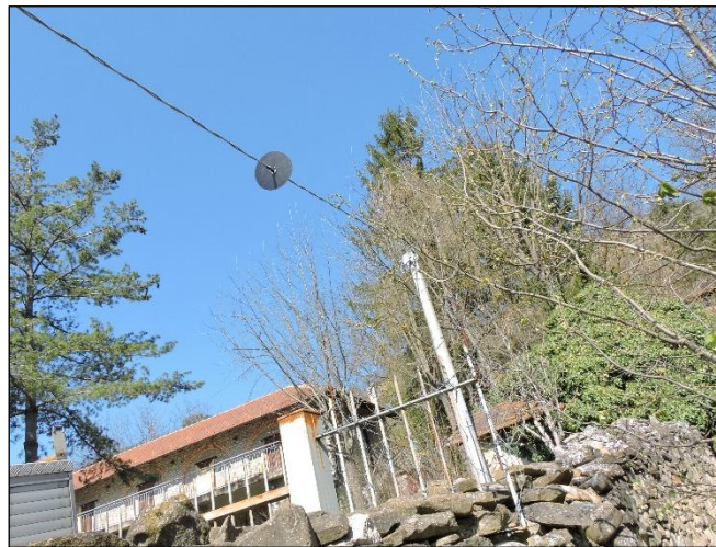
Figura 3. Barriera fisica posizionata su cavo aereo.
