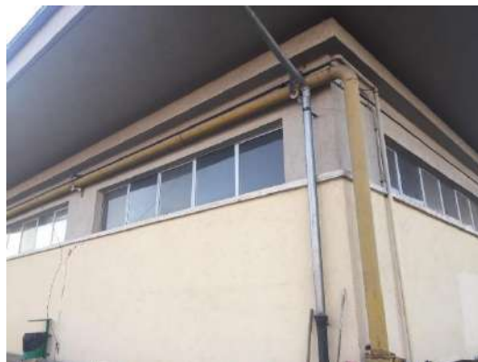
Particolari tubazione gas metano di proprietà della Società di distribuzione
