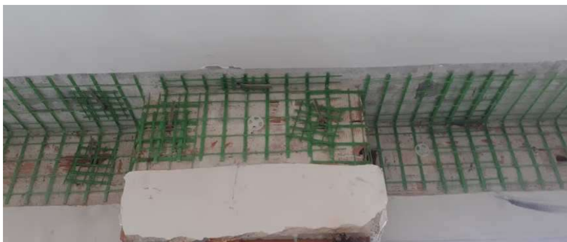
Figura 12 –Fotografia indicativa del posizionamento della rete.
