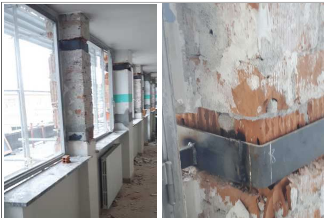
Figura 16 – Fotografie esemplificative del posizionamento delle cerchiature e dei bloccaggi del falso telaio del serramento.
