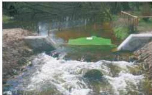
Figura 72. Esempio di cattura con nasse in passaggio a bacini successivi (da Larinier, 2002, modificato) e presso rampe (da DVWK, 2002)
