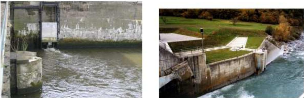
Figura 19. Esempi di collegamento del passaggio all'alveo mediante fenditura verticale (da Gebler, 2005)
