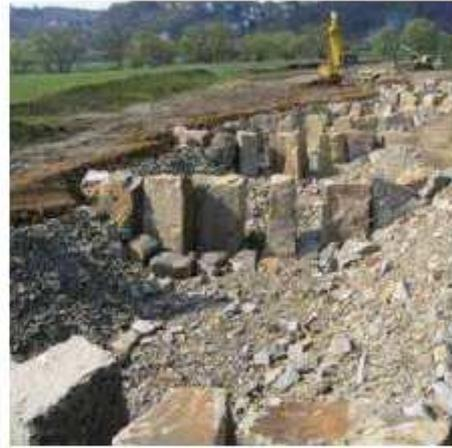
Figura 43. Canale by-pass con soglie in massi in fase di realizzazione (da Gebler, 2007)
