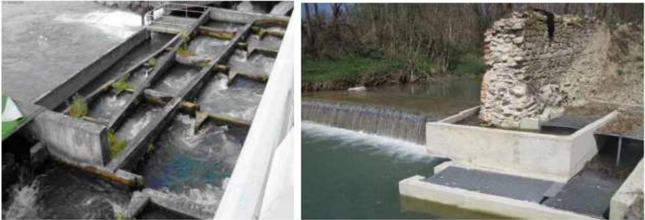
Figura 53. Esempio di passaggio vertical slot e di passaggio pool and weir ripiegato (foto Pini Prato)
