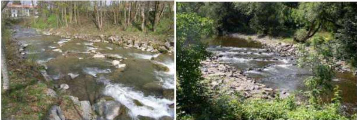
Figura 28. Esempio di boulder bars bottom ramp con soglie "ad alveare" ed "irregolari" (da Gebler, 2007)
