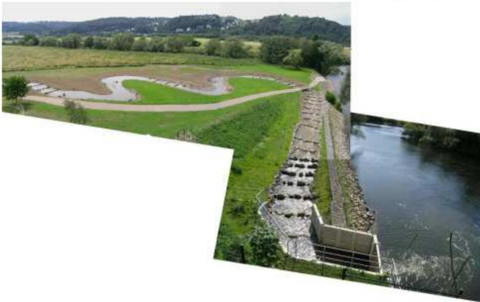
Figura 42. Canale by-pass con bacino finale collegato all'alveo mediante fenditura verticale (da Gebler, 2007)
