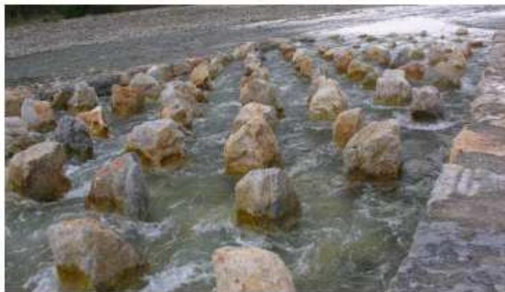
Figura 33. Fish ramp con boulders omogeneamente distribuiti sul fiume Magra (foto Pini Prato)
