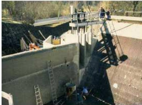
Figura 68. Adeguamento di opera di presa mediante la realizzazione di 2 by-pass ad altezze differenti (da Larinier, 2002)
