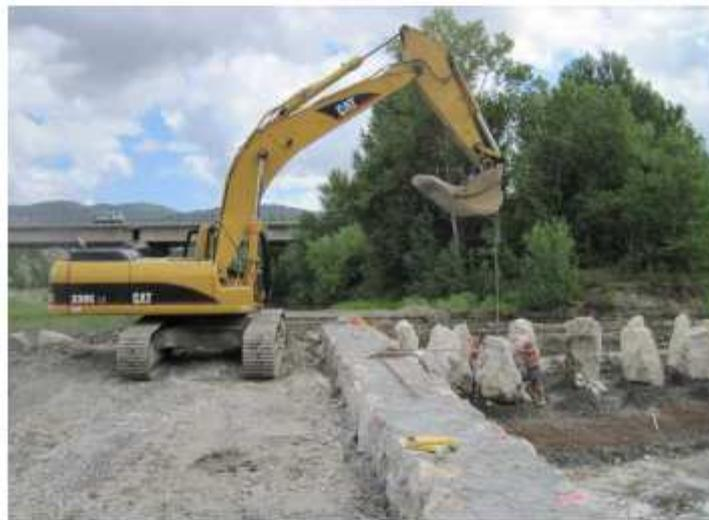
Figura 44. Fish ramp con boulders omogeneamente distribuiti, in fase di realizzazione (foto Pini Prato)
