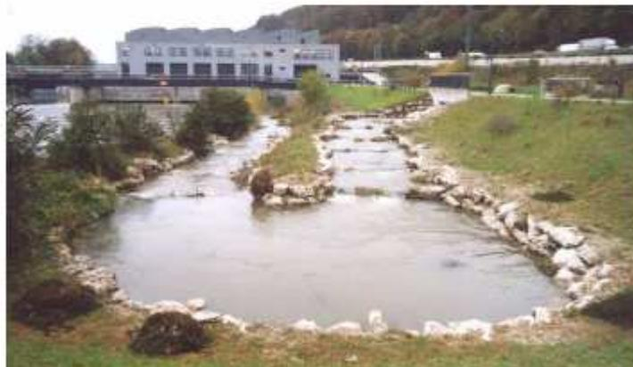
Figura 41. Esempio di canale by-pass con percorso sviluppato a valle dello sbarramento e ripiegato verso il piede dello sbarramento (da Gebler, 2007)
