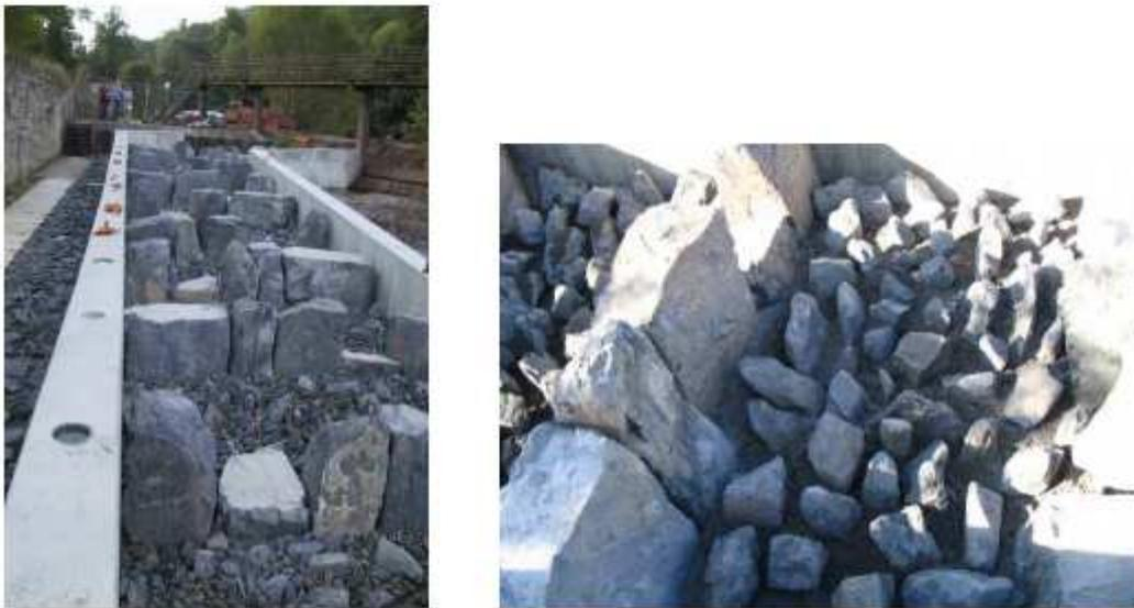
Figura 38. Realizzazione di fish ramp con boulder bars (foto Gorchach)
