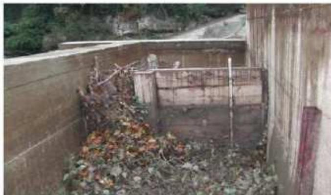
Figura 15. Esempio di passaggio non correttamente funzionante a causa dell'intasamento da materiale flottante e trasporto solido (foto Pini Prato)
