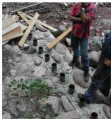
Figura 17. Sistema di barre protettive in corso di realizzazione sulla soglia di sfioro di un passaggio per pesci in ambiente appenninico (Pini Prato, 2003)
