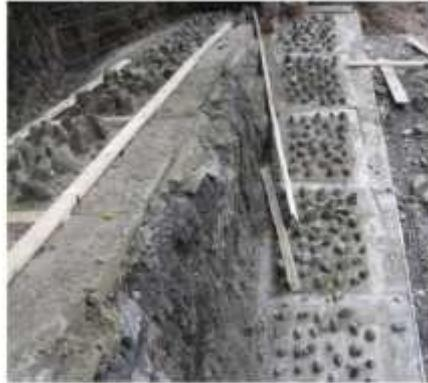
Figura 23. Realizzazione di un substrato roccioso su passaggio per scazzone sul torrente Bisenzio (Pini Prato, 2011)
