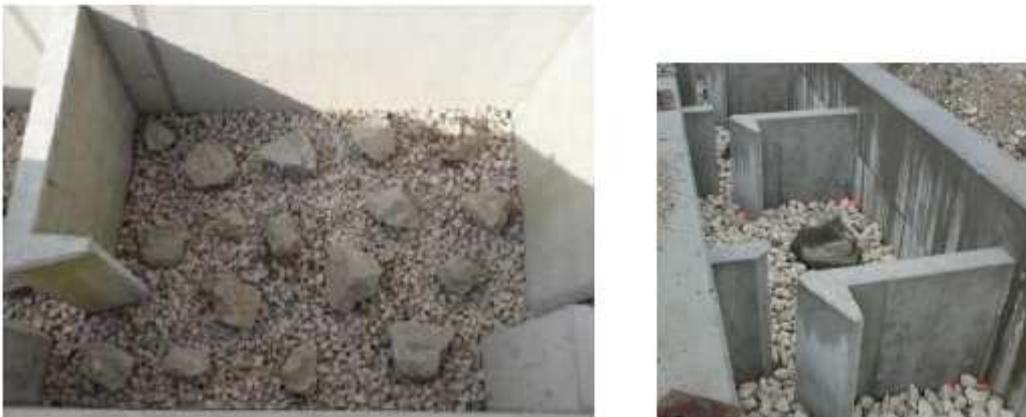
Figura 21. Esempi di substrato di fondo in una vertical slot (da Zitek, 2011 e Rucker e Wittmann, 2005)
