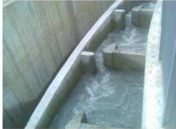
Figura 58. Passaggio vertical slot con canale laterale per portata addizionale (foto Comoglio)
