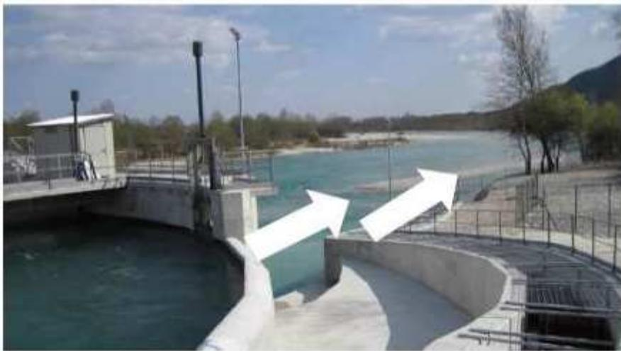
Figura 13. Esempio relativo al caso a): imbocco del passaggio per pesci affiancato a scarico centralina ausiliaria per recupero energetico di quotaparte del DMV su fiume Piave (Pini Prato, 2011)
