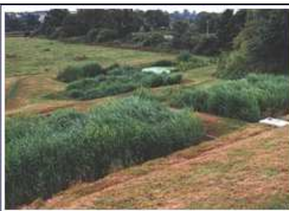
Fig. 9: le medesime vasche di fitodepurazione di Fig. 8, ormai operative
