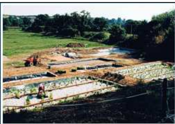
Fig. 8: vasche di fitodepurazione in corso di allestimento
